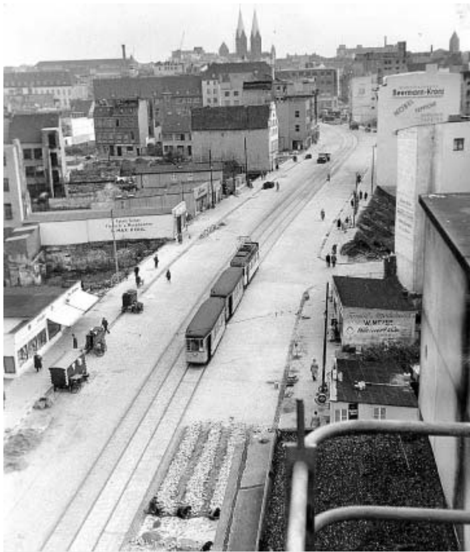
„Der Ausbau der Faulenstraße zwischen Brill und dem Hochhaus am Doventor ist bald beendet. Schon jetzt gibt die neue, 18 Meter breite Fahrbahn einen Eindruck von dem zukünftigen Aussehen dieser alten Geschäftsstraße. Die Straßenarbeiten kosten etwa 400 000 Mark...“ (7. Oktober 1955) FOTO: CLAUS SCHWENKE
